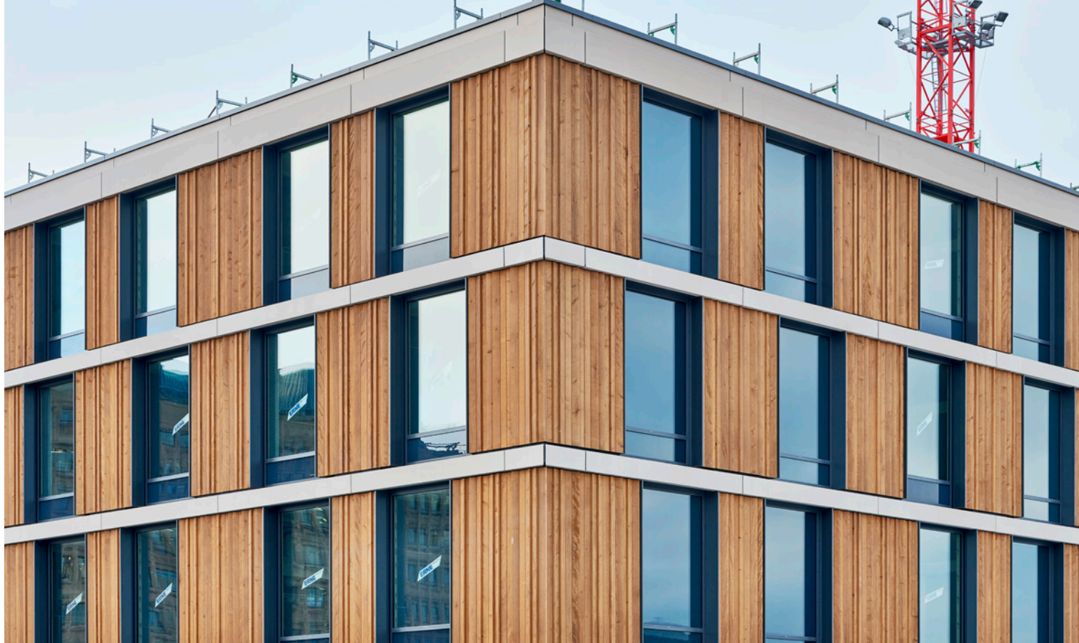
Das Kantonsspital Baden setzt mit einer kreativen Fassade mit Holz aus der Region architektonische Akzente.
