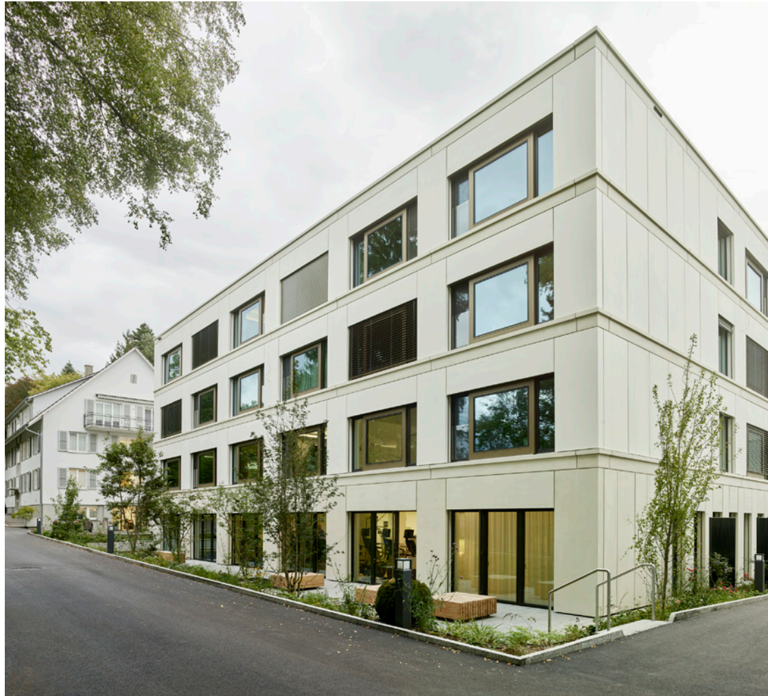
Bei der Privatklinik Linde, Biel, ist eine Fassadenkonstruktion mit vorgefertigten Holzelementen und einer Verkleidung mit Faserbeton und Holz-Metallfenstern in Eiche eingesetzt.
